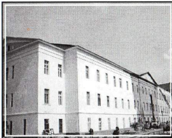
10. Областная больница. Главный корпус (ул.Московская,29)
